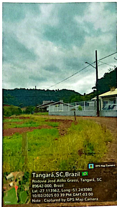
Figura 3. Acesso, não pavimentado, aos lotes, 04, 05, 06, 07 e 08.
