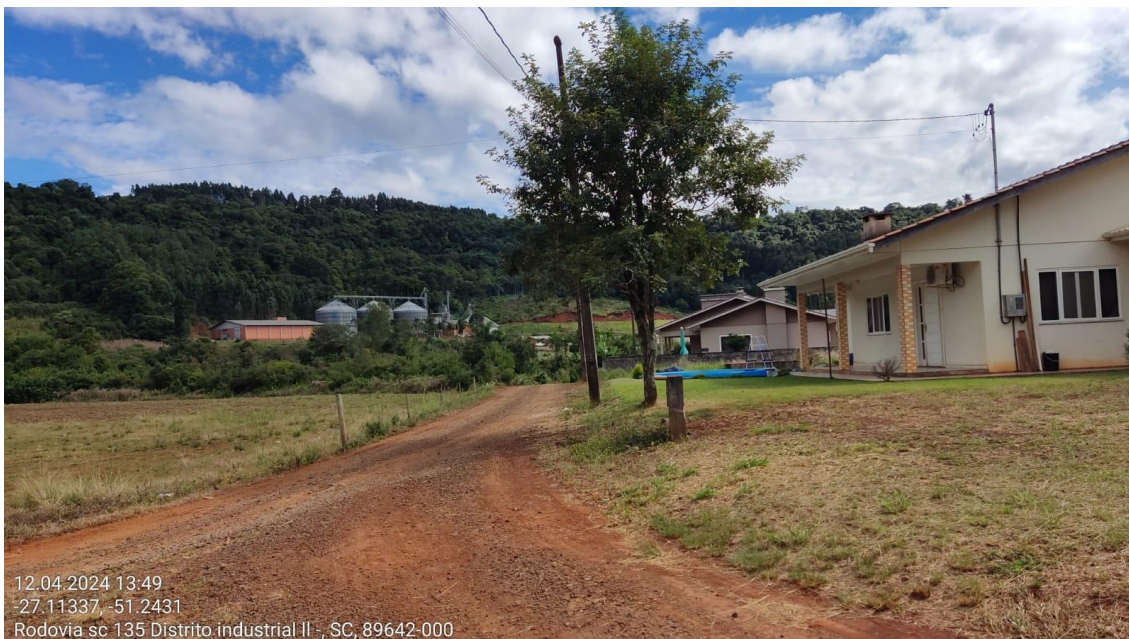
Figura 3. Acesso, não pavimentado, aos lotes, 04, 05, 06, 07 e 08.
